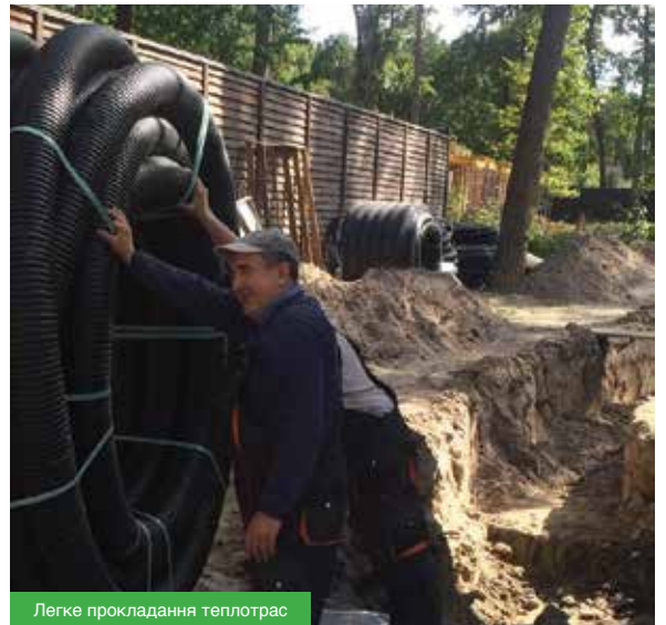
Легке прокладання теплотрас
